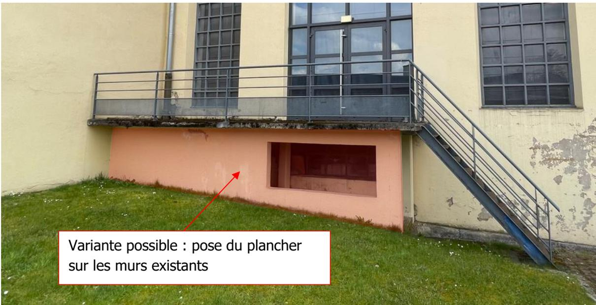
Variante possible : pose du plancher sur les murs existants
