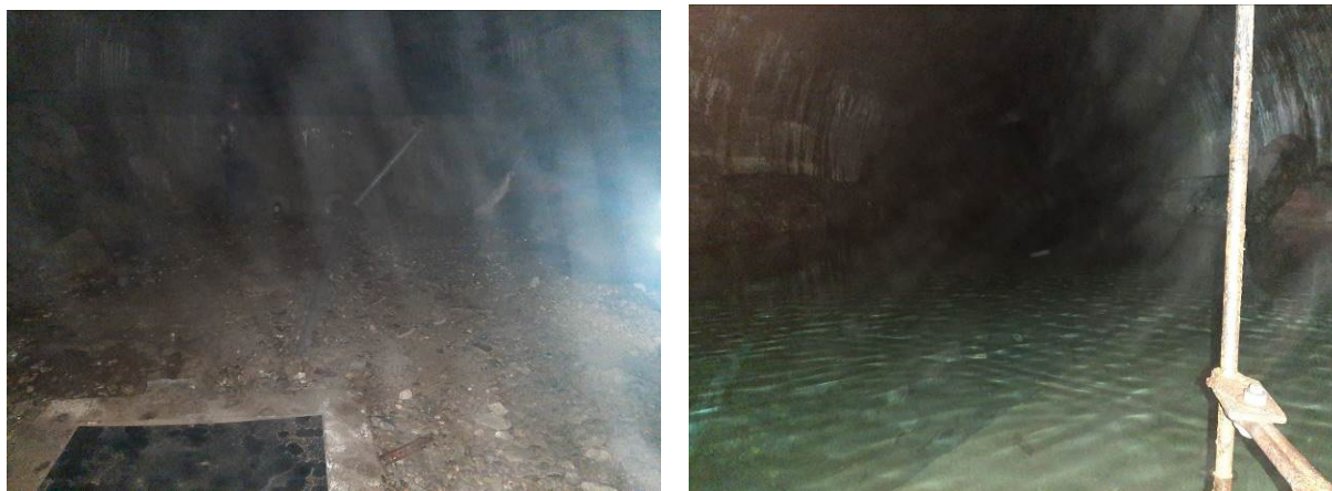
Figure 18 : Barrage et réserve d'eau brute au fond du tunnel
