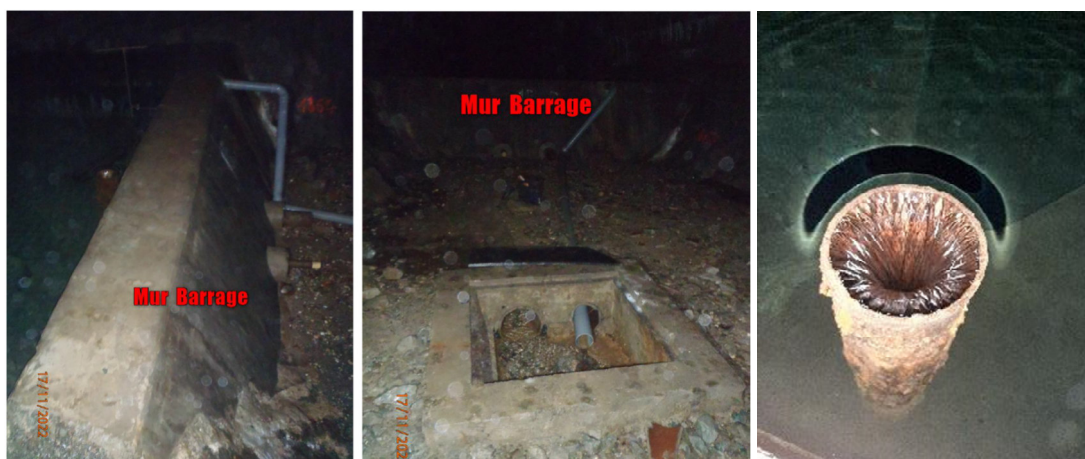
Figure 19 : Mur barrage et trop-plein au fond du tunnel
