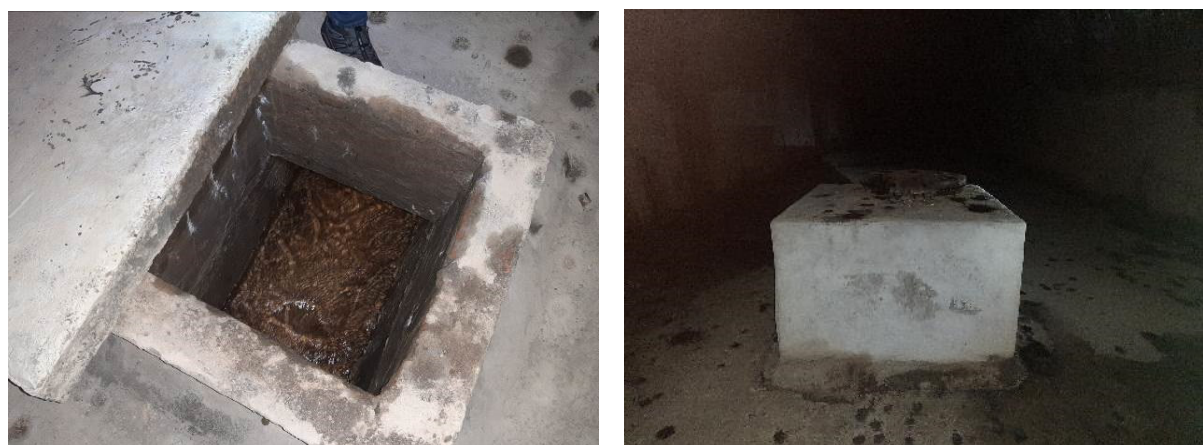
Figure 20 : Canal enterré (dalot) avec regards d'accès
