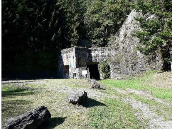
Entrée du tunnel
