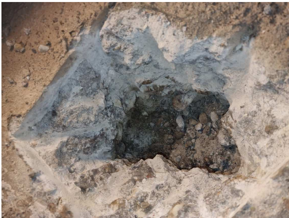
Figure : Sondage S1 pour repérage des armatures dans le dallage
