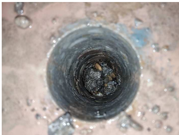
Figure : photo du carottage C4
