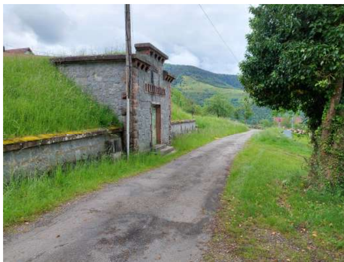
Figure 10 : Photo extérieure de l'ouvrage
