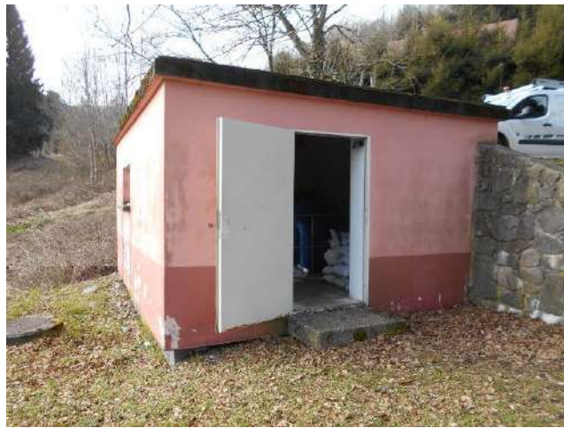
Figure 19 : Photo extérieure de l'ouvrage
