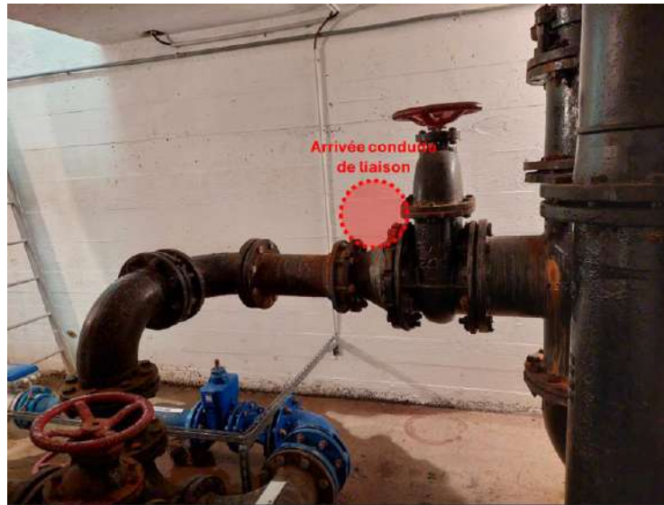
Figure 26 : Carottage/scellement de la conduite de liaison dans la chambre à vannes du Nouveau réservoir
