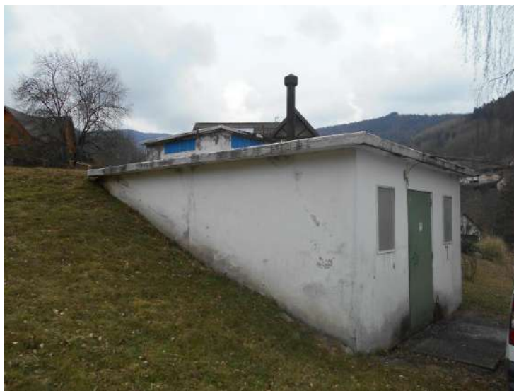
Figure 13 : Photo extérieure de l'ouvrage – Nouveau Réservoir
