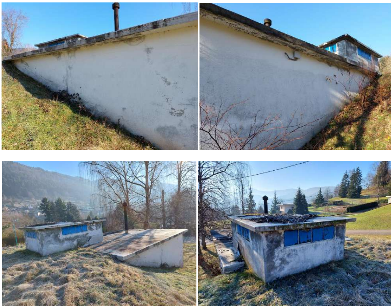
Figure 20 : Etat de l'ouvrage – Extérieur
