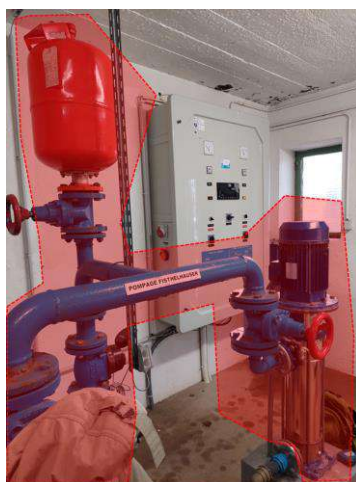
Figure 24 : Remplacement pompes, ballon et refoulement
