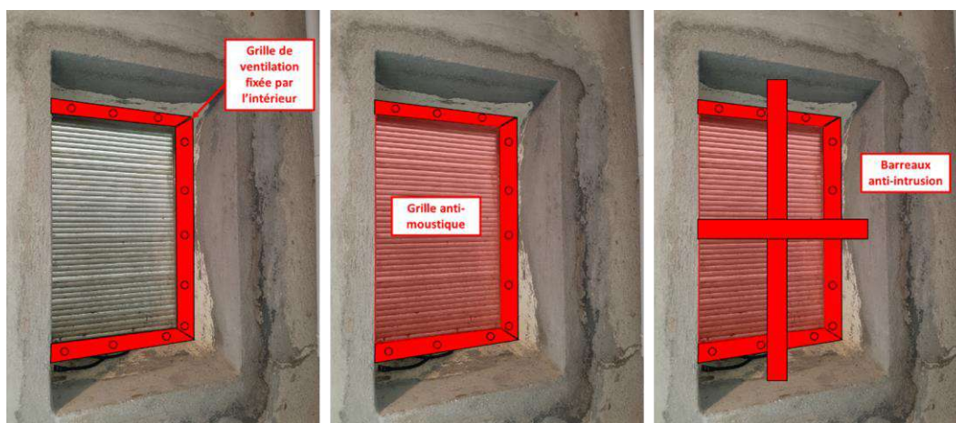
Figure 30 : Principe de reprise des fenêtres en façade
